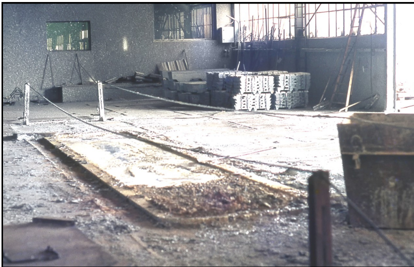
Le bac de zinc en fusion à 700 degrés et « sa protection »
